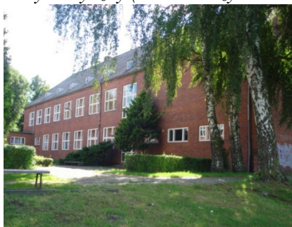
Budynek dydaktyczny (I lewe skrzydło budynku):
